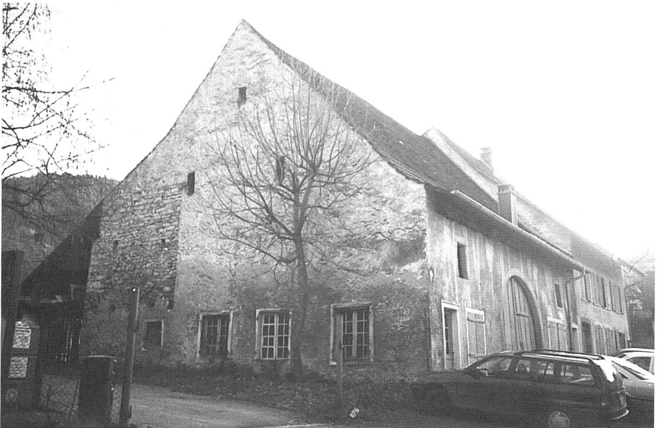
Abb. 14: Ansicht (Ökonomietrakt) von Osten im März 1998. (Foto M. Thommen, Sissach)
