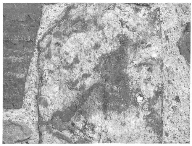
Abbildung 4: Salzausblühungen auf einem Ziegel, der bei einer früheren Mauersanierung eingesetzt worden war.
