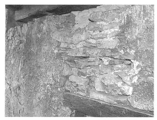
Abbildung 5: Fehlstelle im Verputz unterhalb der Mauerkrone über dem Fenster Nr. 2, dessen Holzgewände aus dem Jahr 1463 stammt. Die Fusspfette des Dachs ist bereits gesichert.
