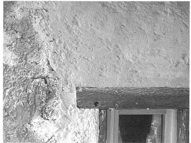
Abbildung 6: Gleiche Stelle wie Abb. 5, nach der Verputzergänzung.
