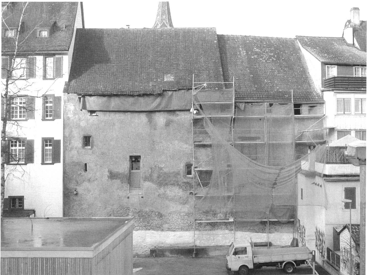
Abbildung 7: Der Stadtmauerabschnitt nach der Sanierung, von Anbauten befreit, während des Abbaus des Gerüsts.
