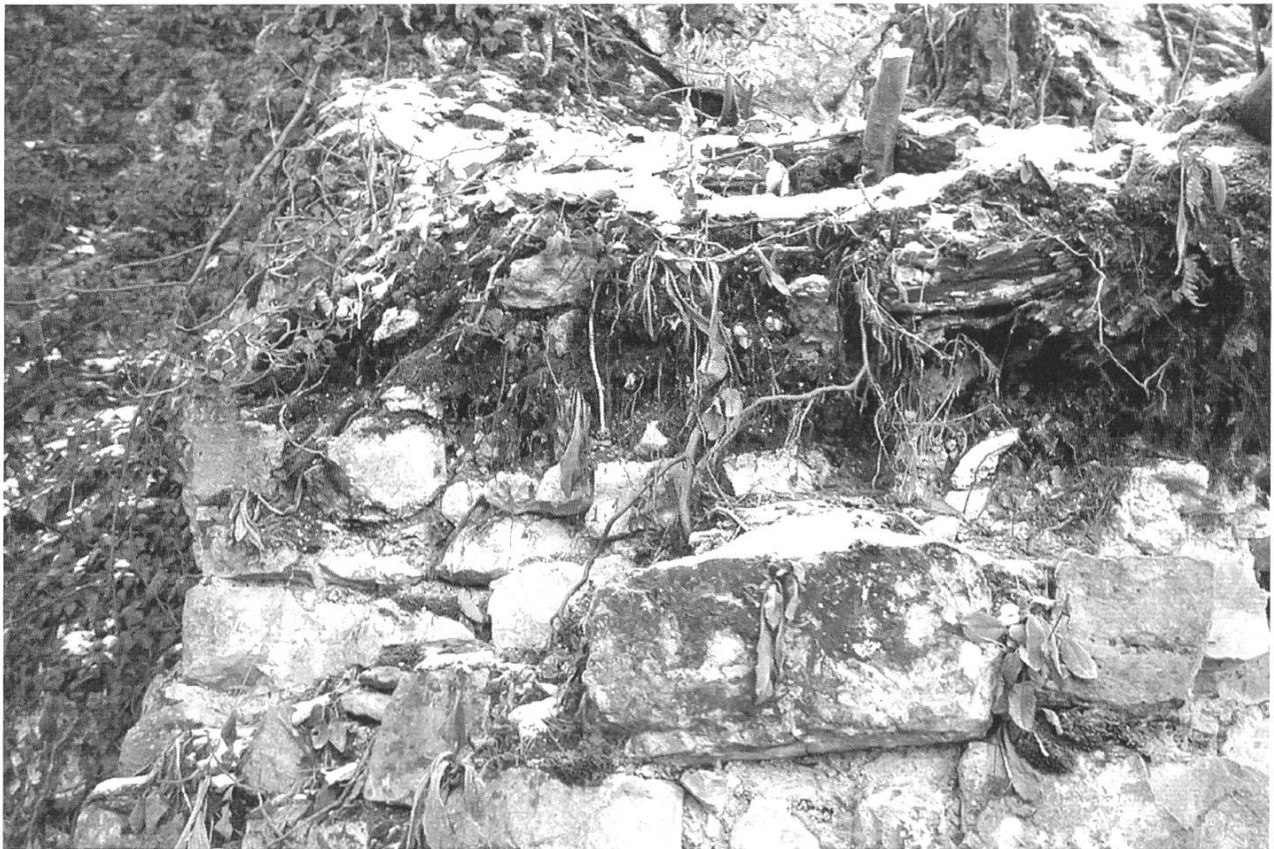
Abb. 3: Ettingen, Burg Fürstenstein. Schäden im Bereich des Einganges. Das Wurzelwerk hat die Mauerkrone vollkommen zerstört, so dass Wasser in den Mauerkerne dringt.
