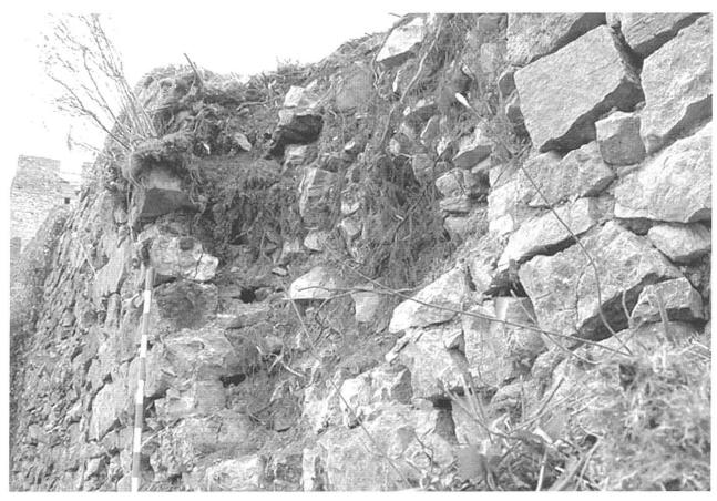
Abb. 7: Waldenburg, Schloss Waldenburg. Der Mauerausbruch am «Neuen Schloss». Es ist deutlich erkennbar, dass auch das umliegende lockere Mauerwerk erneuert werden muss.
