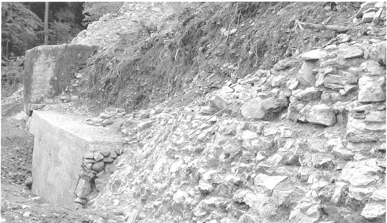
Abb. 6: Buus/Ormalingen/Hemmiken, Farnsburg. Das aus Beton erstellte Fundament für die Rekonstruktion der östlichen Beringmauer. Rechts Reste des Mauerkerens der originalen Mauer und des abgeschroteten anstehenden Felsens.
