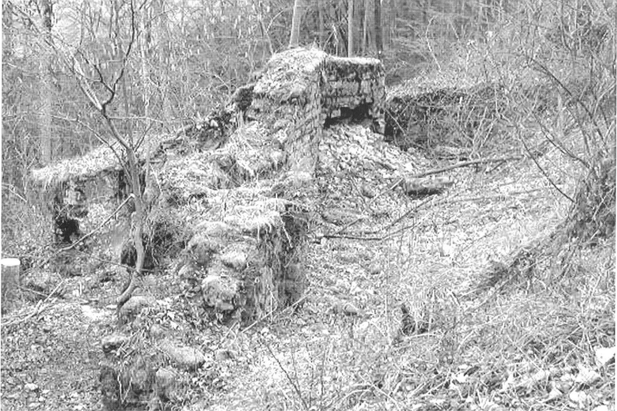
Abb. 4: Buus/Ormalingen/Hemmiken, Farnsburg. Der südöstliche Bereich der Burganlage im Frühjahr 2002 vor der Sanierung.
