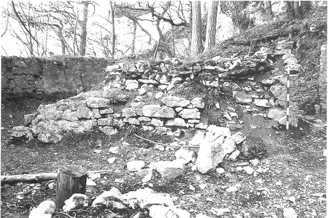
Abb. 2: Eptingen, Burg Witwald. Vom vollständigen Zerfall bedrohter Mauerabschnitt.
