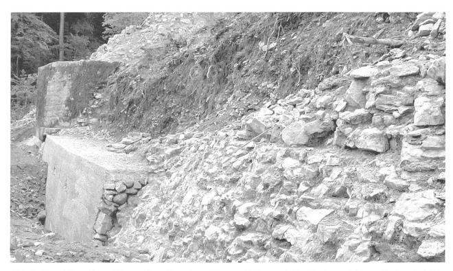
Abb. 6: Buus/Ormalingen/Hemmiken, Farnsburg. Das aus Beton erstellte Fundament für die Rekonstruktion der östlichen Beringmauer. Rechts Reste des Mauerkerns der originalen Mauer und des abgeschroteten anstehenden Felsens.
