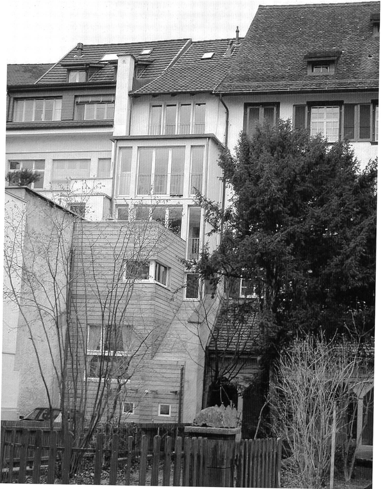
Erneuerter Anbau im Bereich des Stadtgrabens.
