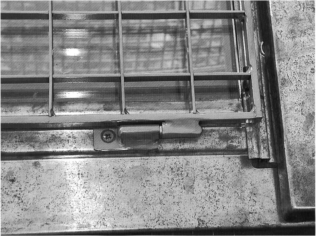
Detailaufnahme Dachfenster «Typ Ortskern».
