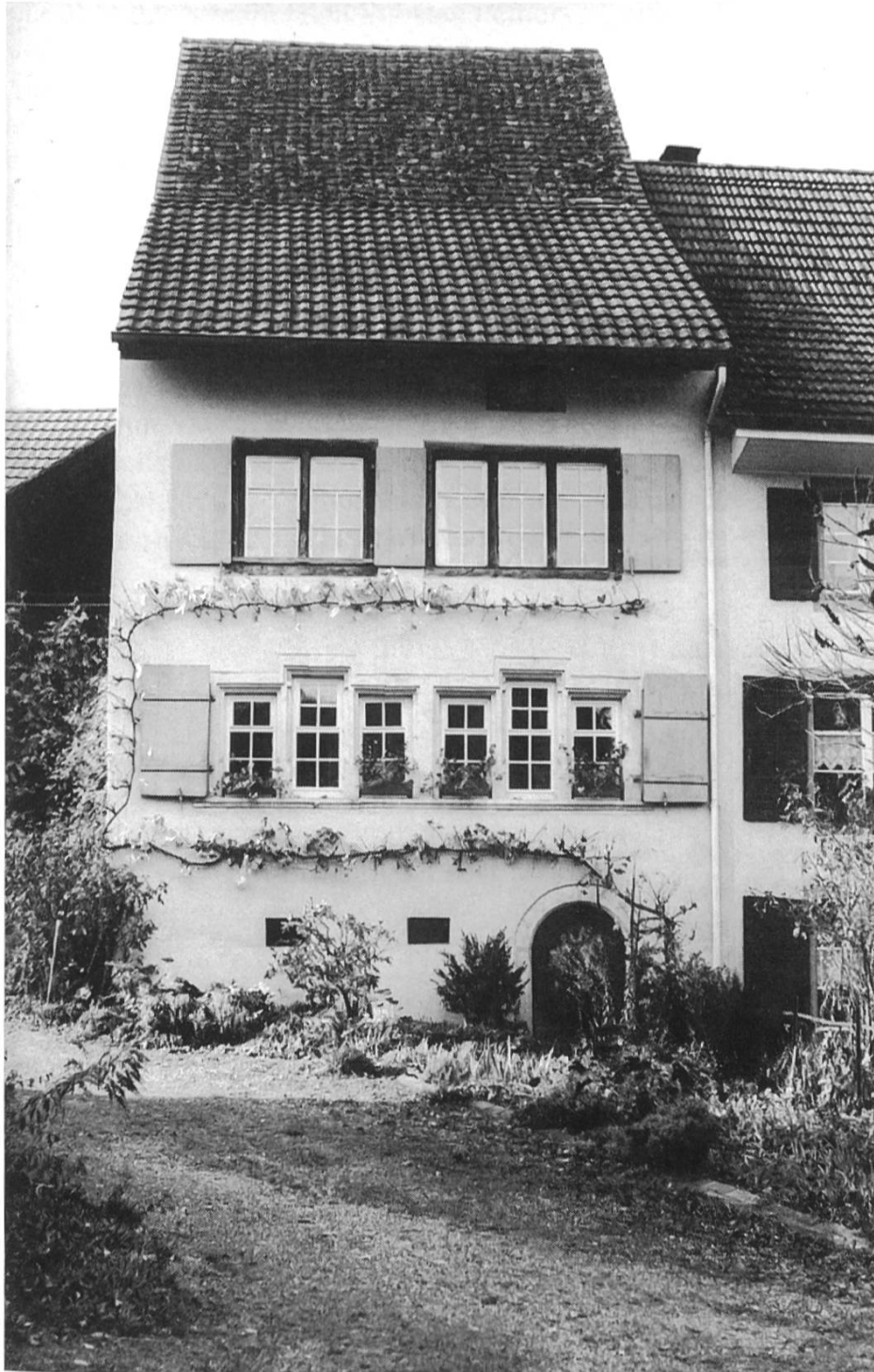
Abbildung 8. Fassade zur Kirchgasse, Zustand seit der Erhöhung von 1741 (Foto U. Gruner)
