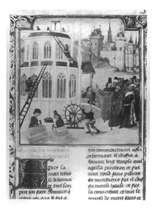
Abbildung 2: Bildliche Darstellung eines Kirchenbaus im 15. Jahrhundert. Die Werksteine werden mit dem Aufzug, der Mörtel in Körben von Bauleuten auf Leitern hochgetragen. (Scheidegger, Abb. 46, Seite 204)
