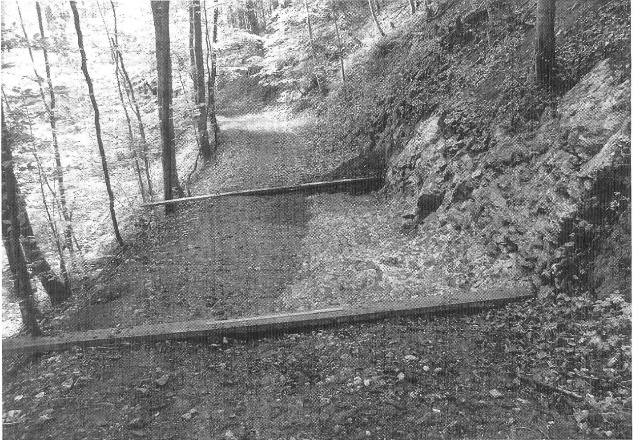
Abb. 7: Freigelegter Wegabschnitt im unteren Bereich.
