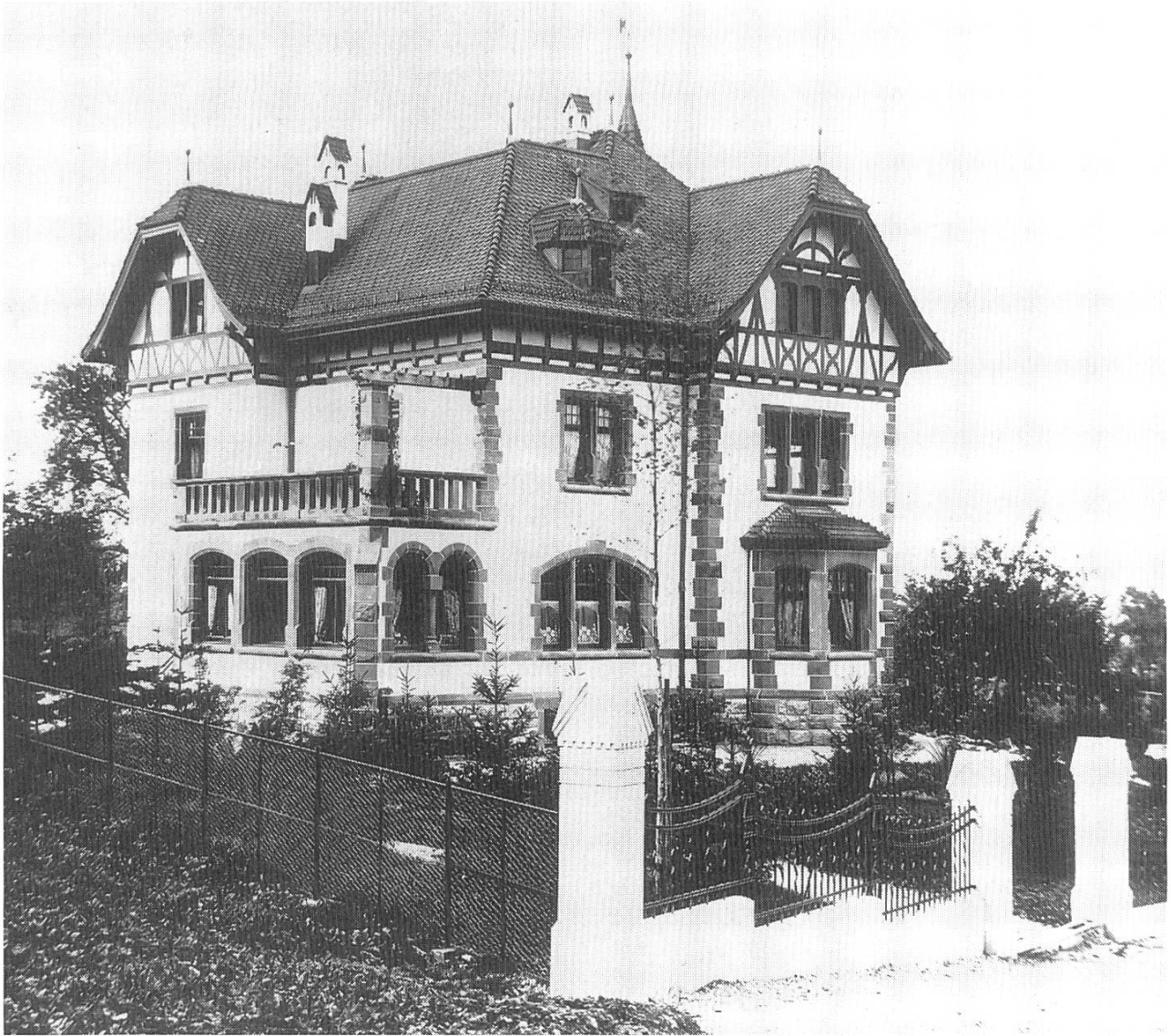
Die Villa von Alexis Garonne am Liestaler Tiergartenweg kurz nach der Fertigstellung im Jahre 1904 (StA BL; Repro: F. Gysin, Mikrofilmstelle BL)
