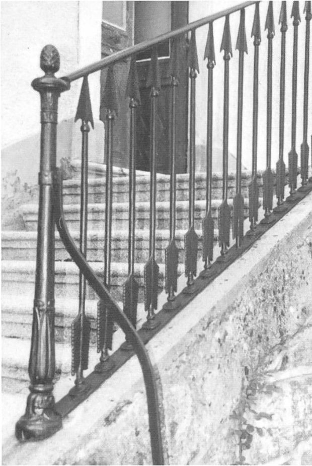
Gegossenes Geländer der Freitreppe zur «Grossen Kellerei» in Lucelle.
