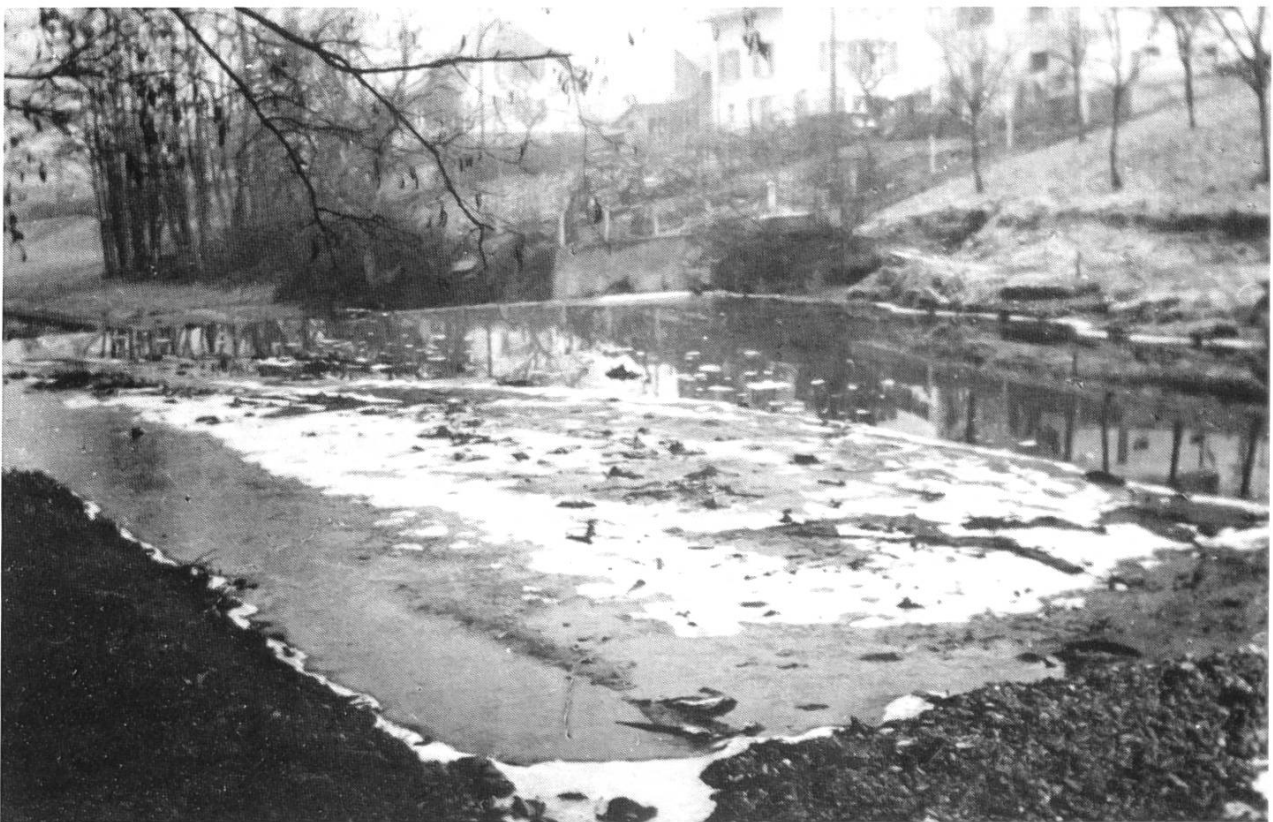
Abb. 15: «29. Dezember 1932. Ergolz unterhalb des Wehrs zum Kanal der untern Fabrik in Niederschönthal. Ablagerung von Faulschlamm, welche bei Hochwasser weiter abwärts (bis Augst) geschwemmt werden.» Bild und Kommentar aus: «Untersuchung über die Verschmutzung der Ergolz, 1932»: (Quelle: StA BL, Bau Q 1.1a).
