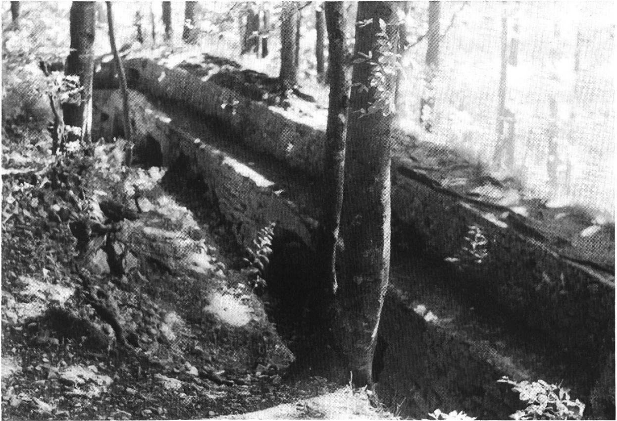
Bild 5. Laufgraben am Spitzenflüeli.
