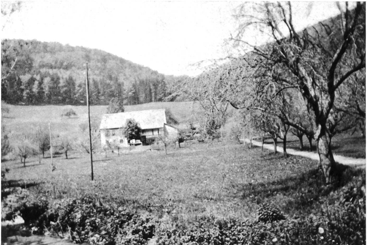
Bild 1. Gesamtansicht des Hofes Fraumatt bei Ziefen vor dem Abbruch (1977). Blick gegen Westen, im Vordergrund Hintere Frenke und Zufahrtsweg zum Hof.
