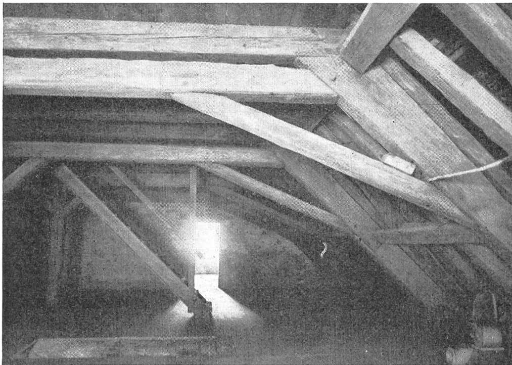
Bild 5. Mühle und Wohngebäude. Zweiter Dachboden mit Treppe zum dritten Dachboden. Im Vordergrund Einstieg zur Treppe zum ersten Dachboden. Photo Microfilmstelle Baselland.
