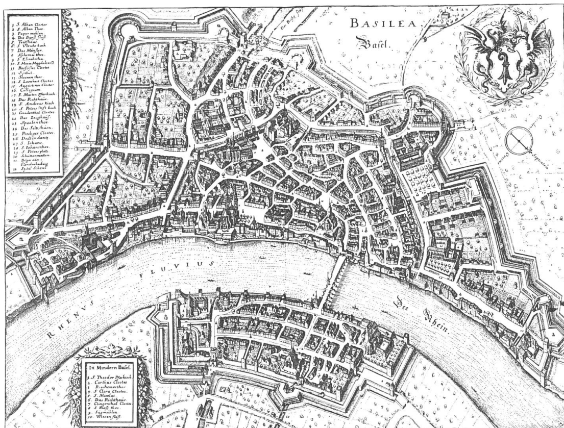
Bild 1. Vogelschaubild der Stadt Basel im Jahre 1642 aus der « Topographia Helvetiae » von Math. Merian. Zur Erhöhung der Sicherheit waren die Befestigungen (Mauern, Bastionen, Tore und Türme) nach französischem Muster verstärkt und erweitert worden. Die Ueberbauung des Areals war noch unvollständig; grosse Grünflächen (Wiesen, Rebland, Gärten) fanden sich innerhalb der Mauern.
