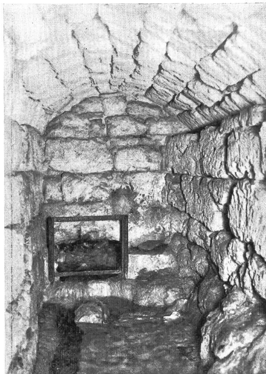
Bild 2. Das Gewölbe mit der Quelfassung der Gallislochquelle bei Oltingen. Photo Emil Weitnauer.
