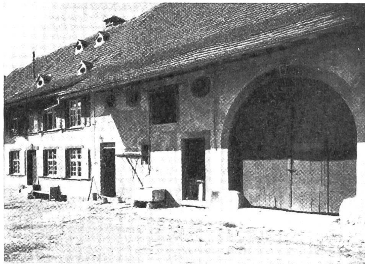
Bild 2, Bauernhaus in Binningen. Schönes Beispiel für verspäteten Barock. Anfang 19. Jahrhundert. Reihenfolge: Wohnteil, Stall, Scheune. Photo Ochs, Basel.
