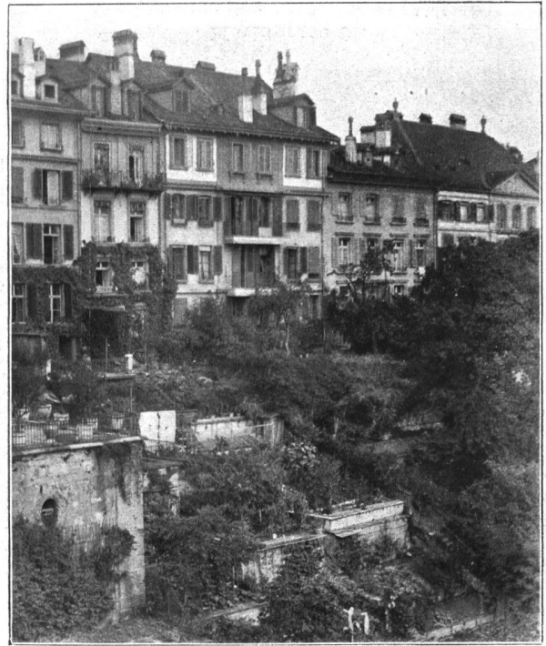
Südseite des 6 Fenster breiten Hauses Junkerngasse 51. 1768—1772. (Abb. 17.)
