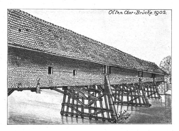
usw. Die Joche trugen die Fahrbahn, welche auf zwei starken Langhölzern ruhte, die als "ansböme" <sup>54</sup>) bezeichnet wurden. Letztere verbanden Querhölzer oder dicke Laden, welche die Fahrbahn bildeten. Zum Schutz gegen die Witterungseinflüsse diente ein die Brücke deckendes Schindel- oder Ziegeldach, welches überdies den Vorteil verminderter Schneebelastung bot. Die Brückenenden ruhten auf den Widerlagern
