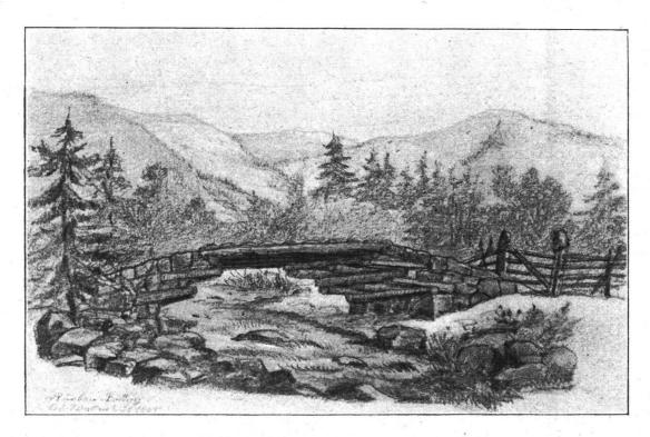
Gürben-Brücke bei Wattenwil, Kt. Bern 1805. (Balkenbrücke durch Ueberkragung.)
