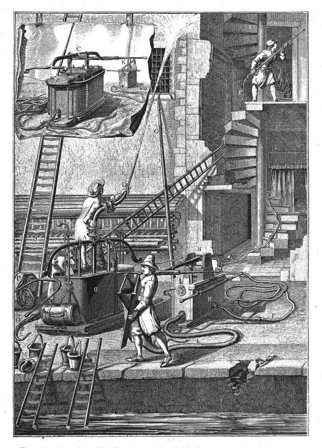
Fig. 10. Die alte Wenderohrspritze und die neue Schlauchspritze.
