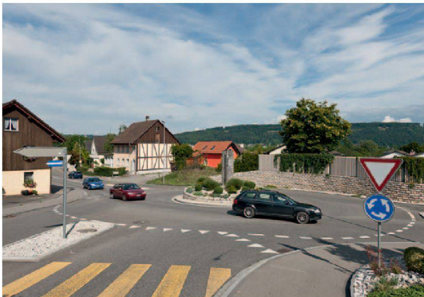
Gebenstorf, Landstrasse/Kinziggrabenstrasse, bei der alten Turnhalle. Der Wasserschlosskreisel in Gebenstorf ist typisch wegen seiner unterhaltsarmen Gestaltung, atypisch, weil er nicht vier Strassen in sich aufnimmt.
