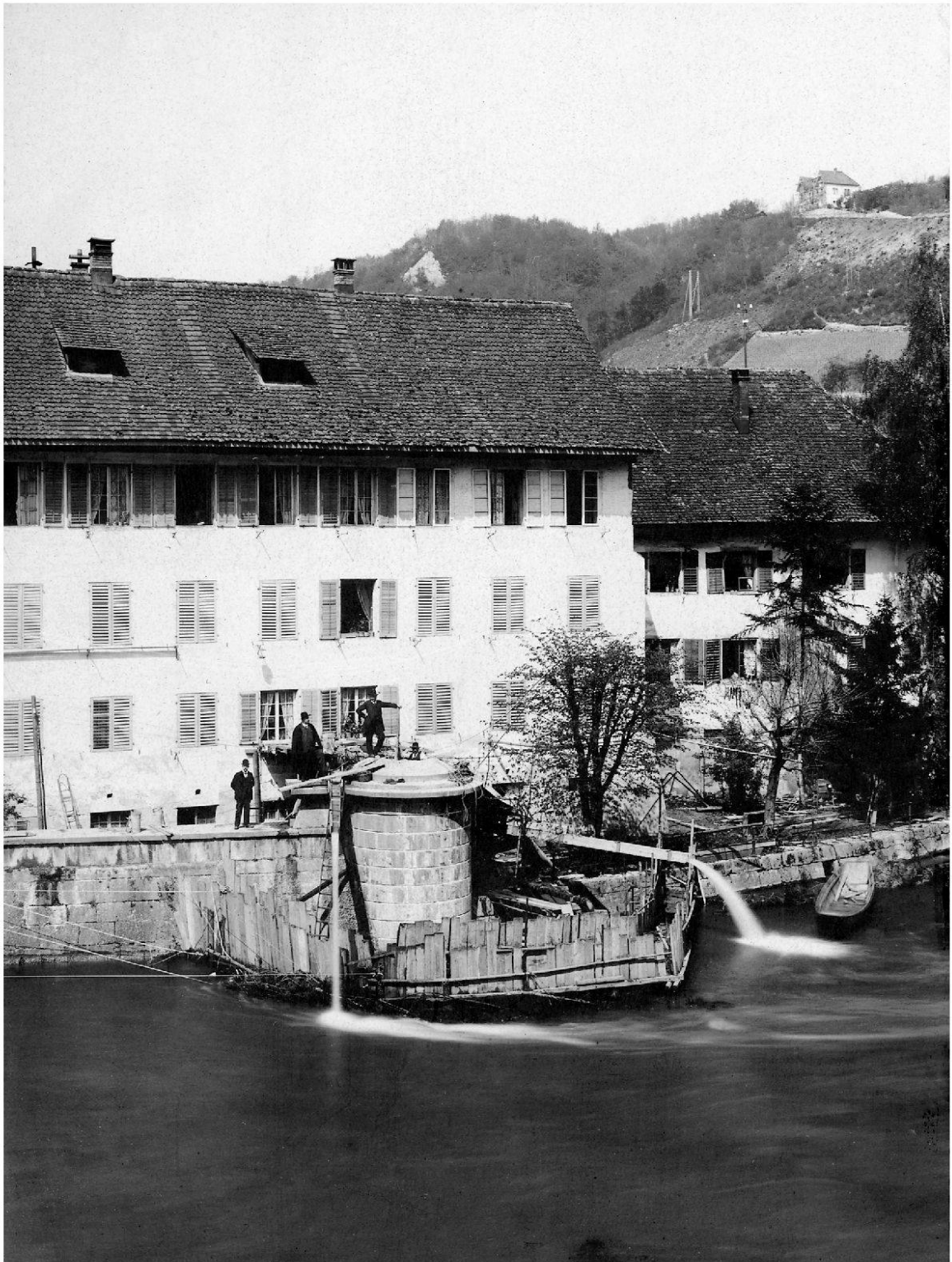
Aufwändige Nerfassung der Limmatquelle im Jahr 1904, da- hinter Schweizerhof und Staa- dhof. Rechts oben das Restaurant Hertenstein im Bau (Bild: Stadt- archiv Baden, Nachlass Robert Witzig, N 10.1.7)
