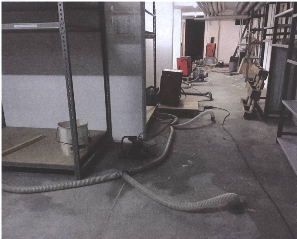
Trocknung des geleerten Depots mit diversen Entfeuchtungsgeräten.
