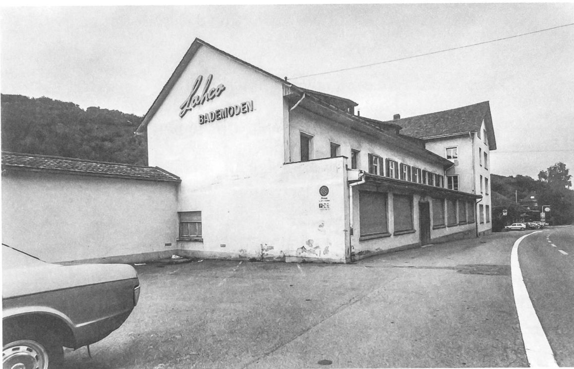
... und kurz vor dem Abbruch im Januar 1986.
