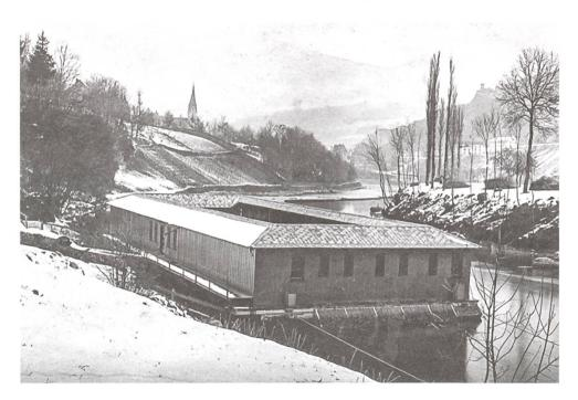
ten. Ein Hochwasser drang 1910 in die Caissons ein und brachte die Anlage zum Sinken. Das Wrack konnte nicht wieder flottgemacht werden. Es wurde gehoben und abgebrochen.
