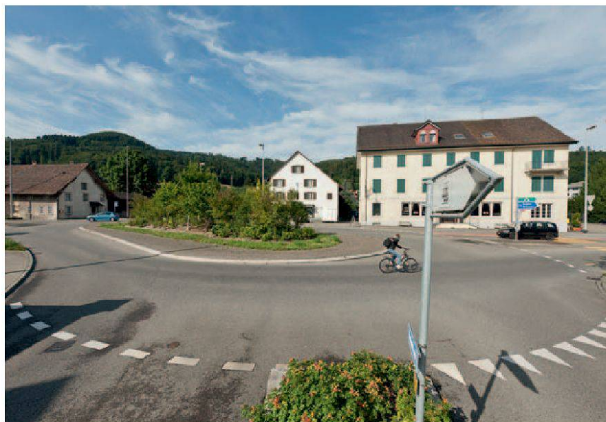
Neuenhof, Zürcherstrasse, vor dem «Posthorn». Die Verkehrsanlage vor dem Neuenhofer Posthorn hat eigentlich Erdnussform und musste schon abgeän- dert werden.
