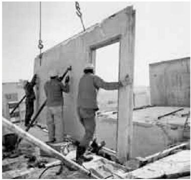
Abb. 10: Auf horizontalen Stahltischen wurden Wandelemente in der Fabrik fixfertig vorbereitet.
