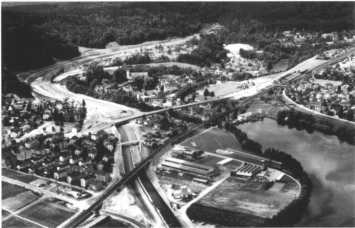
Bild oben: Gleichzeitig mit dem Bau der Autobahn wurde die Hoch- brücke nach Wettingen rea- lisiert, welche die ungenügen-
