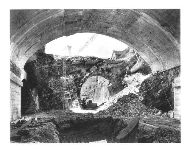
Tunnelbaustelle vom Nordportal her aufgenommen. Nach der Bahnverlegung in den neuen Tunnel unter dem Kreuzliberg wurde der bestehende alte Schossbergtunnel von den SBB frei gegeben, und die Bauarbeiten für den neuen, grösseren Autotunnel konnten beginnen. Zu erkennen ist der alte Bahntunnel und der neu entstehende Autotunnel, unter den später die Tunnelgarage und die Zufahrt zur Zivilschutzanlage Stein zu liegen kamen. (Foto Werner Nefflen)
