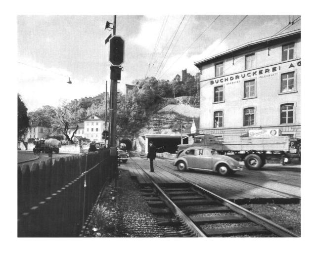
Der neue Bahntunnel ist bereits gebaut, die Züge verkehren aber noch durch den alten Tunnel links davon. Für die bevorstehenden Arbeiten am neuen Strassentunnel musste die Rütistrasse Richtung Baldegg saniert werden. Rechts im Bild ist das alte Gebäude der Buchdruckerei AG Baden zu sehen, das für die Einführung der Bahngeleise in den neuen Tunnel abgerissen wurde. Ebenfalls abgerissen wurde eine Häuserzeile auf dem Gstühlplatz, um der Bruggerstrasse Platz zu
