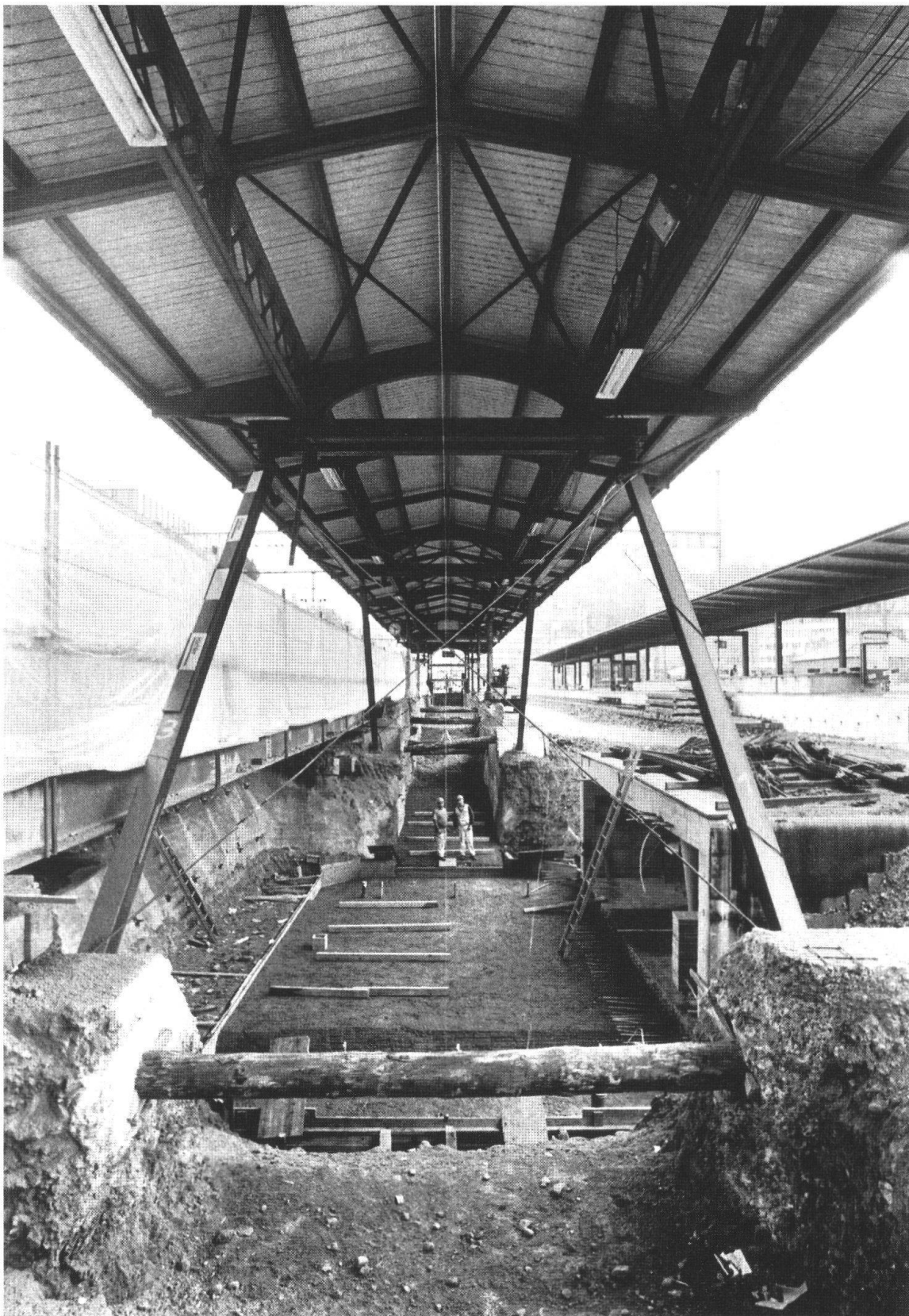
Zentrale Personenunterführung kreuzt Gleis 2 und 3, 7. Oktober 1999.
