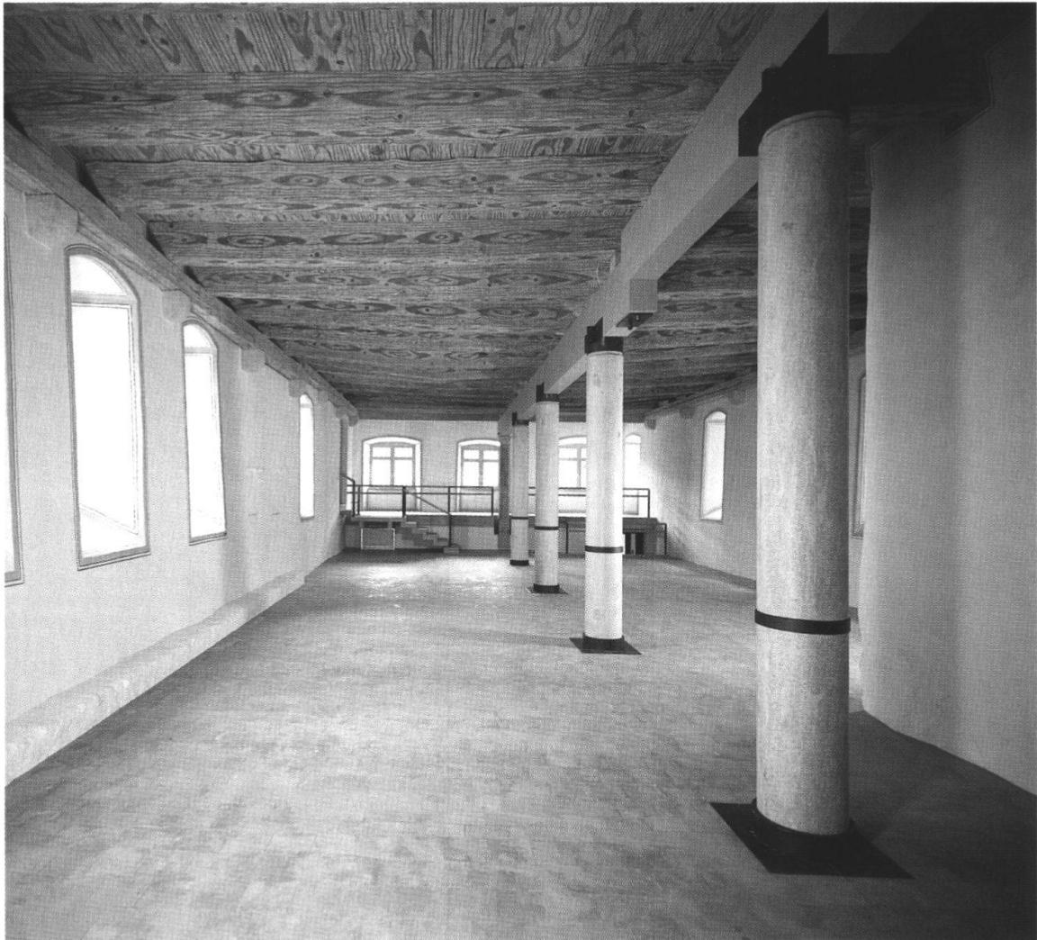
Abb. 2 Der wiederhergestellte Mönchssaal wird von der mächtigen Balkendecke aus der Gründungszeit des Klosters beherrscht. Die Raumhülle (Wände, Fenster, Bodenbelag und Deckenbemalung) ist im Zustand von 1600 zur Darstellung gebracht. Die mittlere Deckenabstützung, die Ausgestaltung der Galerie im Hintergrund etc. sind dagegen bewusst modern gestaltet.
