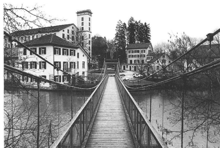
der den Weg der Arbeiter in die Fabrik abkürzte. Die 42 Meter lange Brücke wurde durch vier Paralleldrahtkabel von drei Zentimeter Durchmesser getragen. 1982 sanierten die Gemeinden Neuenhof und Wettingen die Brücke mit neuen, zur Verstärkung angebrachten Kabeln.
