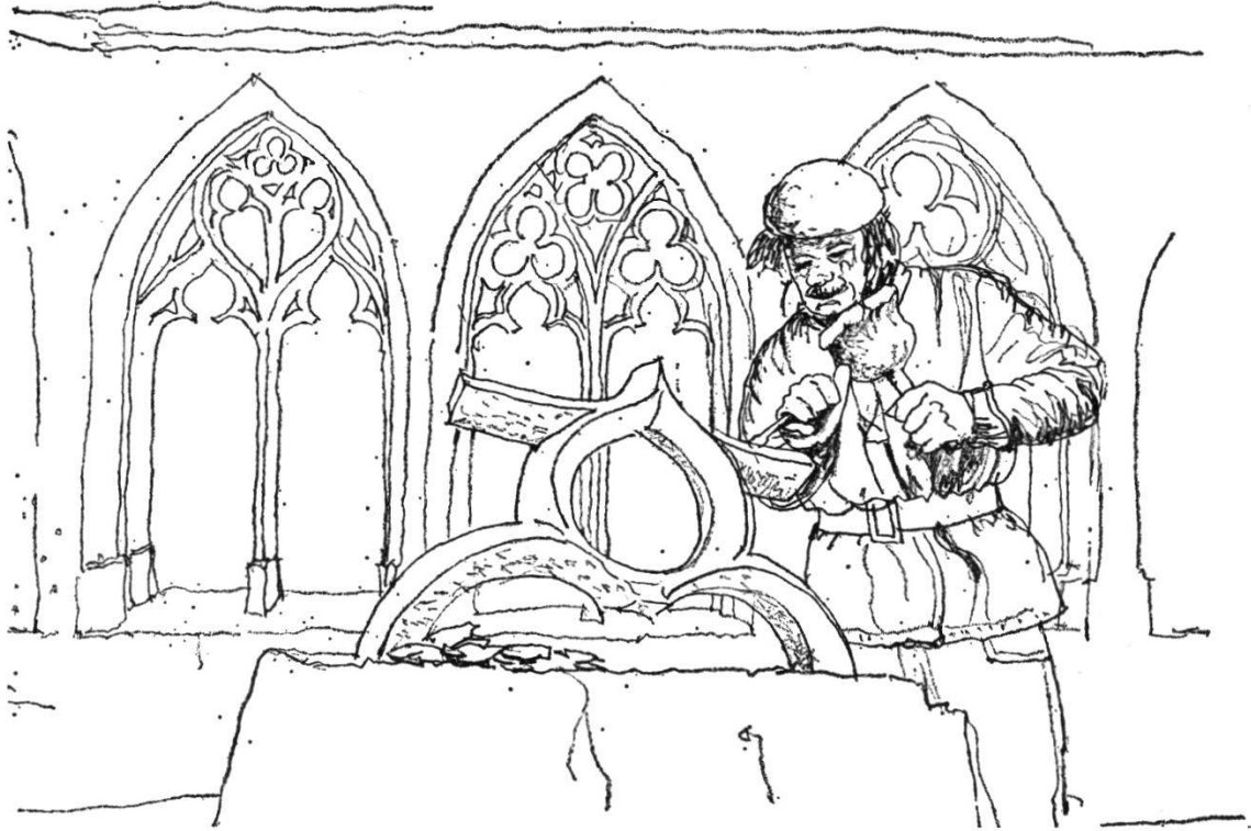
Steinmetz arbeitet an einem Masswerk im Kreuzgang Wettingen
