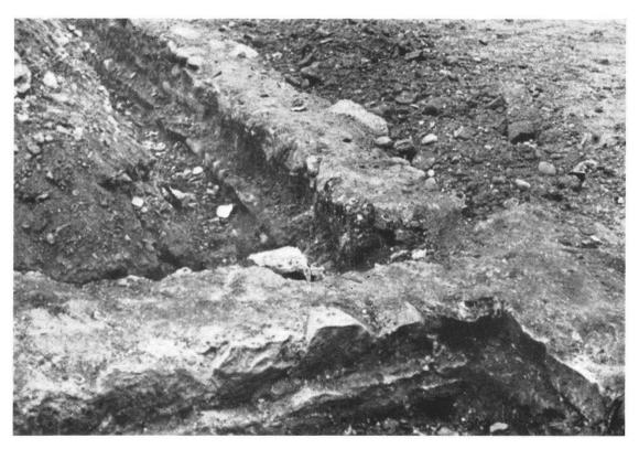
Fundamentmauern aus Kalksteinquadern mit Vorfundamenten an der Kreuzungsstelle der Südmauer (von oben links nach unten rechts ziehend) mit der Westmauer. Das Mauerwerk steckt heute noch unter dem Zuschauerraum des neuen Kurtheaters.
