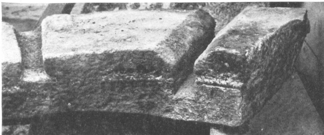
Abb. 10 Teil des alten Verteilerkranzes. Abb. 8, 9, 11, 12 Photo: Schaich (Bauamt Baden)
