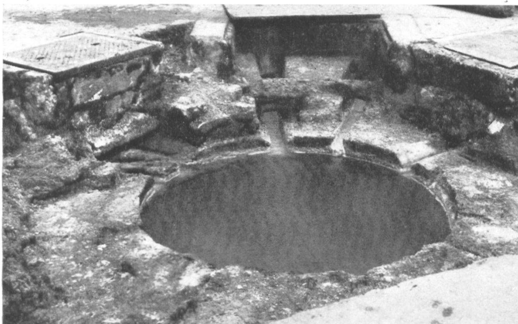
Abb. 9 Quellfassung unter dem Grossen Heissen Stein mit dem alten Verteiler aus Granit, der (v. l. n. r.) folgende Rinnen zeigt: Grand Hotel, Schweizerhof, Stadtanteil, Zufluss der Ki. Quelle, Blume.
