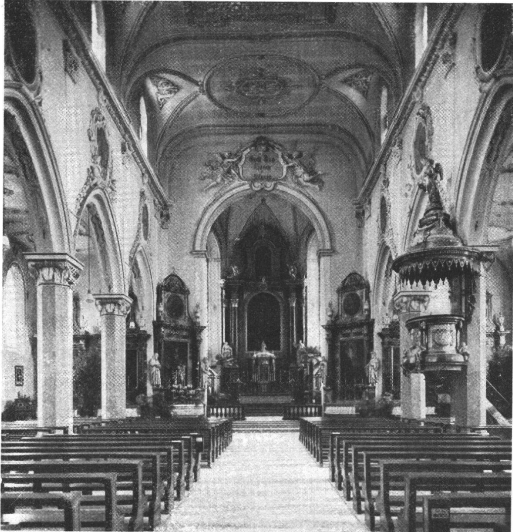
Innenansicht vor der Restauration
