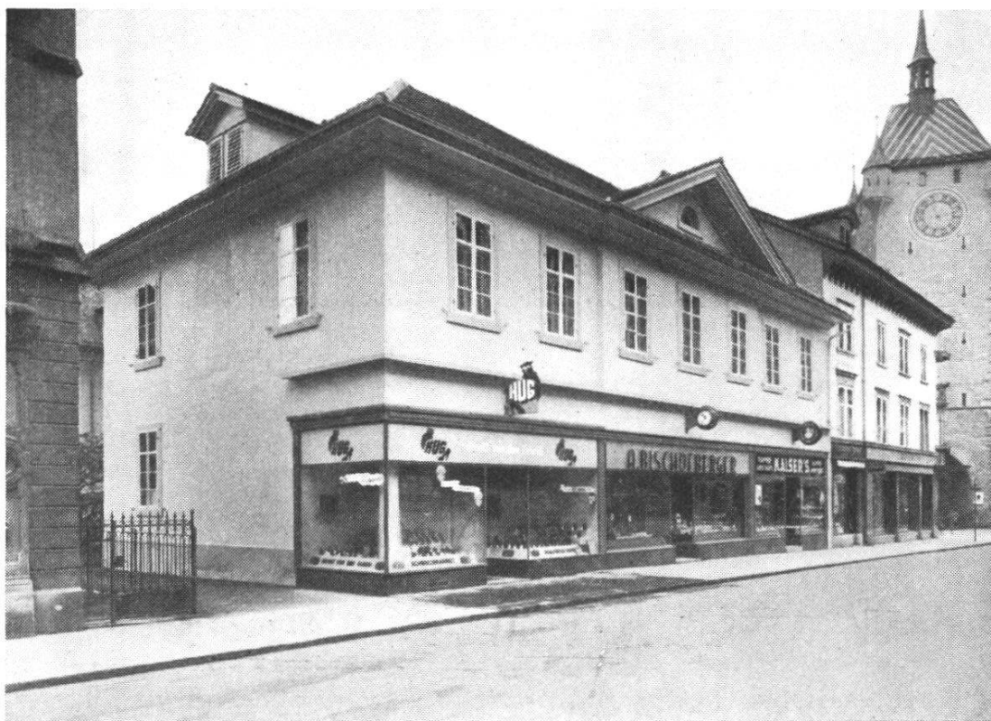
Nach dem Umbau 1936
