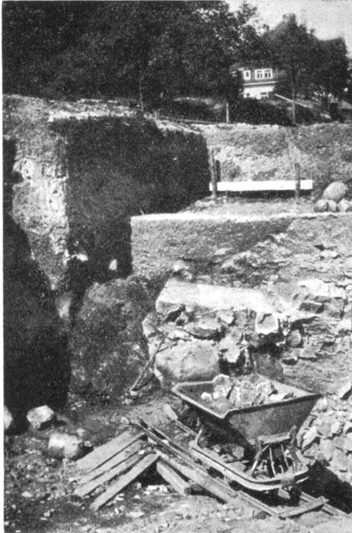
Ausbau für die Fundamente des Turmbaues. Blick nach N.O. Rechts die nach S fallenden Kalkbänke. Links unten Bohnerztasche. Darüber flache Mulde mit Moränenausfüllung sowie erratischen Blöcken.
