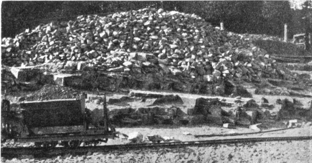
Baustelle des Hauptgebäudes. Standpunkt: Terrasse 403,6. Wangener Kalke mit deutlicher Bankung. Schichtfallen gegen Süden, also gegen den Beschauer. Fundstelle der Versteinerungen. Darüber weggesprengtes Material.
