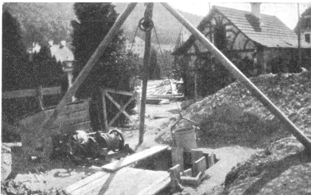
Blick auf den zukünftigen Turnplatz, 400 m. Der 26. Schacht wird gegraben. In ihn kommt der Pfeiler zu stehen, der die Ostede des Treppenaufgangs zu tragen hat. Das Häuschen gehörte zum Tennisplatz und beherbergt z. Z. das Baubureau.
