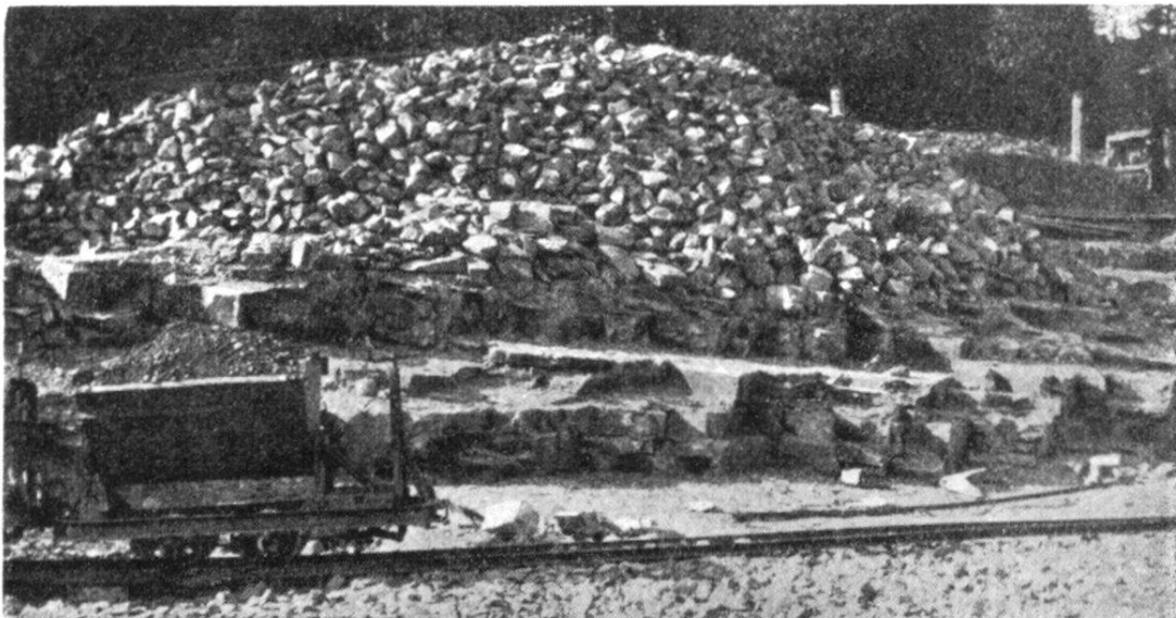
Baustelle des Hauptgebäudes. Standpunkt: Terrasse 403,6. Wangener Kalk mit deutlicher Bankung. Schichtfallen gegen Süden, also gegen den Beschauer. Fundstelle der Versteinerungen. Darüber weggesprengtes Material.
