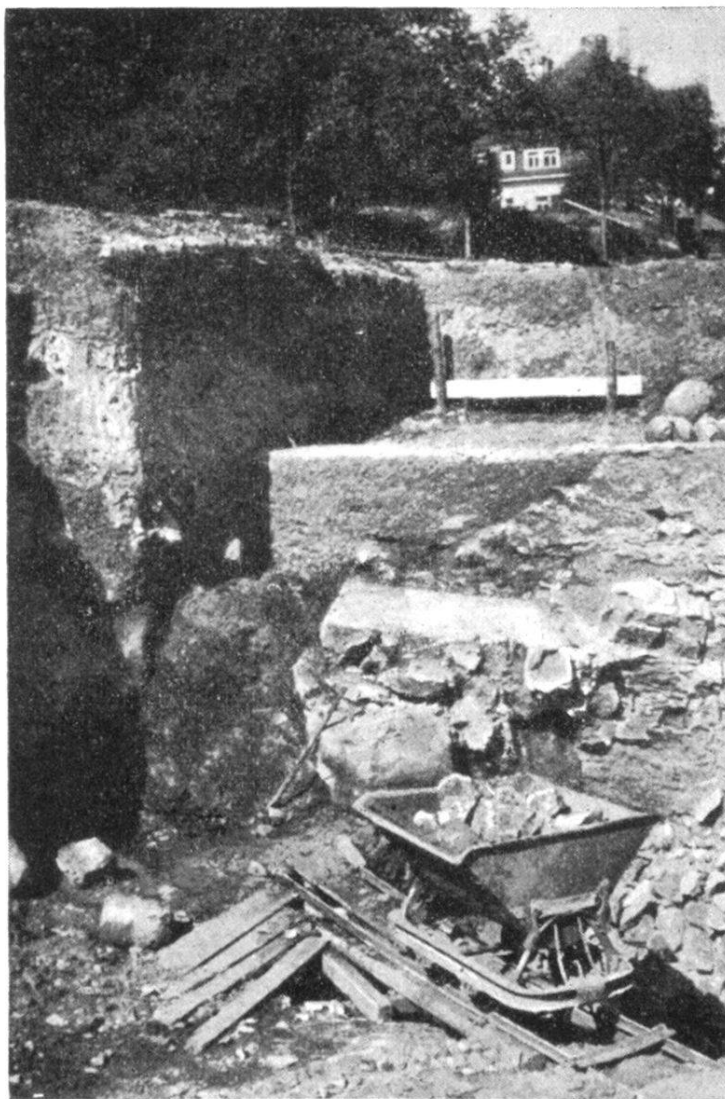
Ausgrab für die Fundamente des Turmbaues. Blick nach N.O. Rechts die nach S fallenden Kalkbänke. Links unten Bohnerztasche. Darüber flache Mulde mit Moränenausfüllung sowie erratischen Blöcken.
