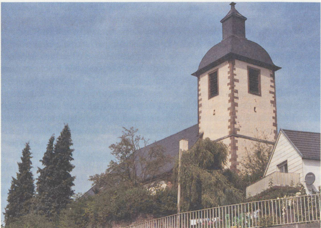
Evangelische Kirche in Contwig, im Bauzustand von 1785
