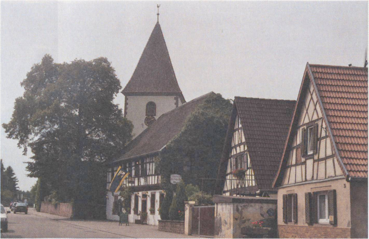
An der Dorfstrasse in Queichhambach
