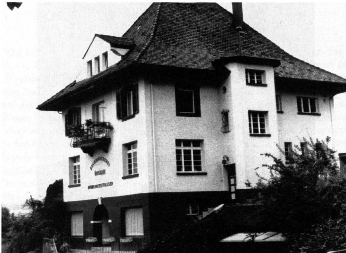
Das Druckereigebäude der Hochstrasser in Dottikon, 1929 erbaut (Fam. Hochstrasser).
