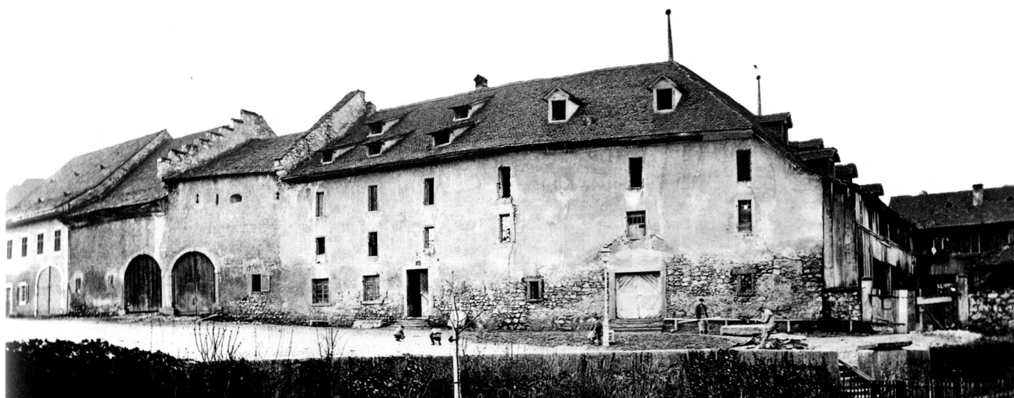
Das Salzmagazin, 1798 als Kaserne eingerichtet, 1877 abgebrochen. Auf dem Grundstück steht der heutige Saalbau. Archiv Sauerländer AG.
