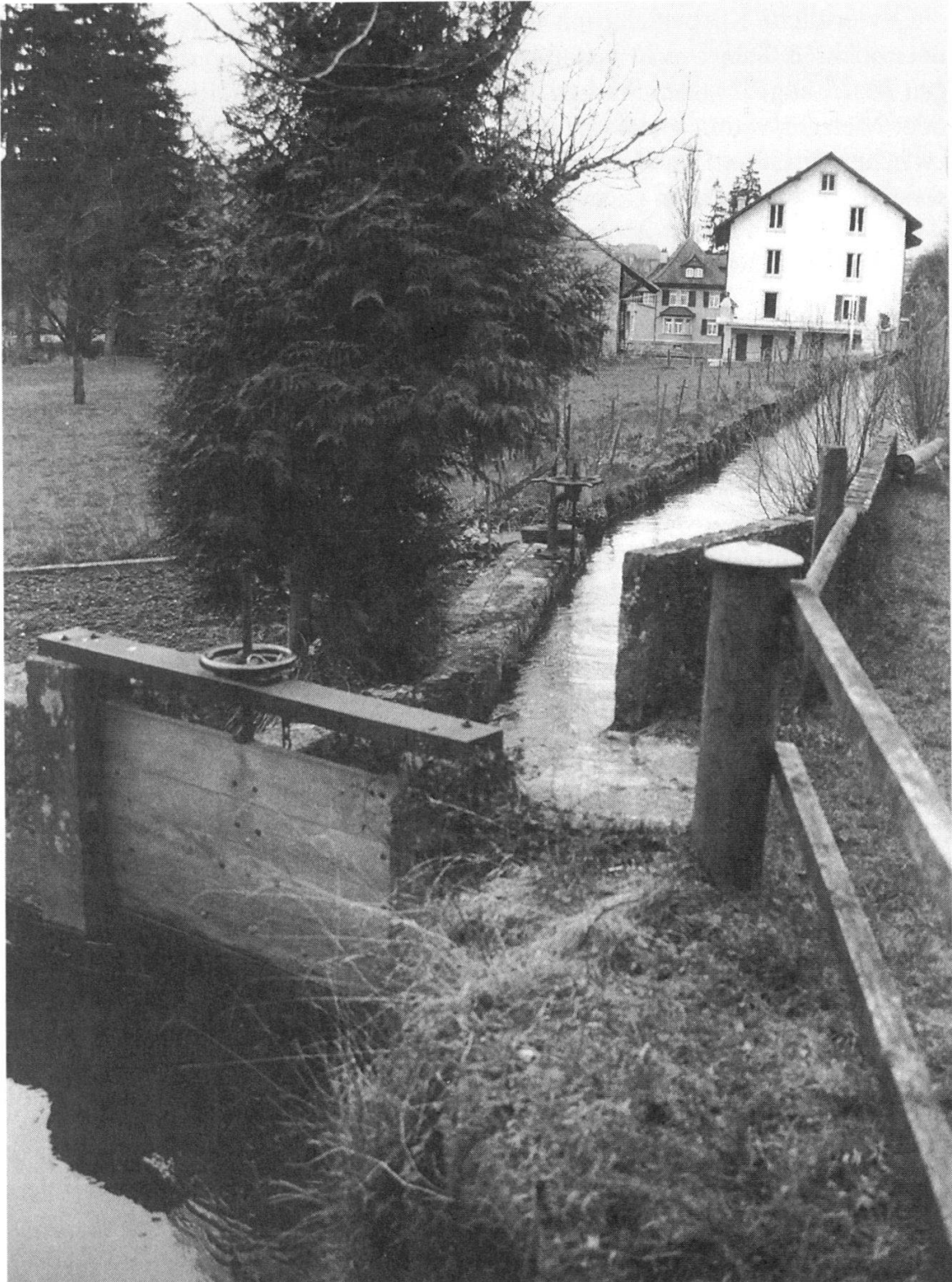
Abb. 69 Wehr und Wassergraben zur Mühle Endingen im heutigen Zustand. Die Mühle liegt am oberen Dorfrand und wird durch einen aus der Surb abgeleiteten Wassergraben gespeist (Foto DS).
