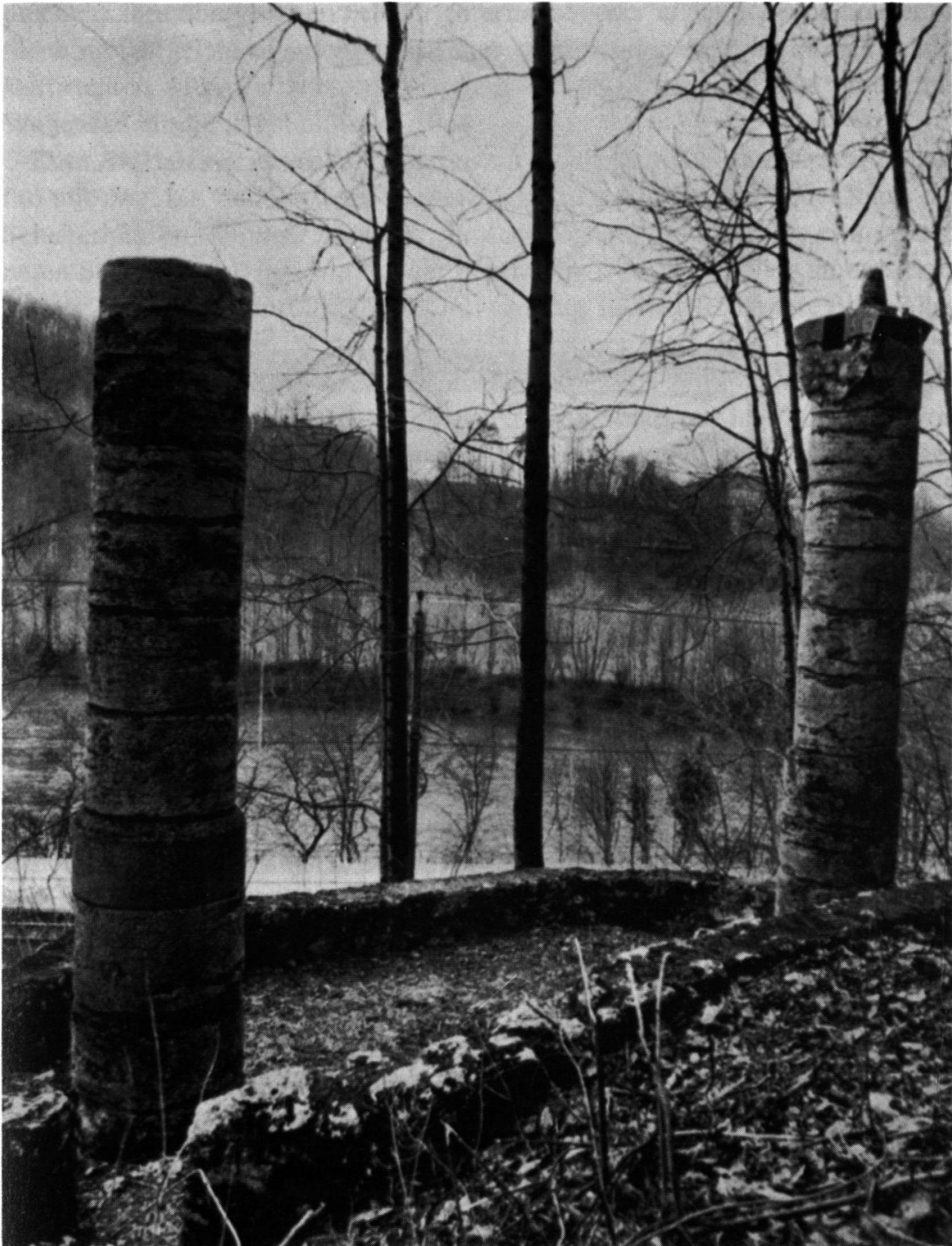
Abb. 18 Der 1935 wieder aufgerichtete Galgen von Aarburg
