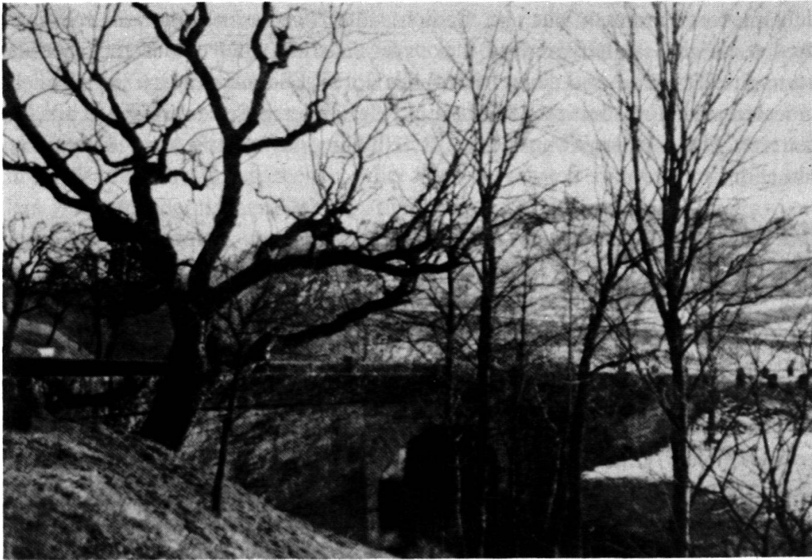
Abb. 31 Letzte Erinnerung an die Schallenwerker: Schällebrugg an der alten Staffeleggstrasse, erbaut 1806–1810
