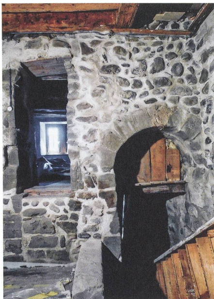
↑ Fig. 8 Rue du Château 15. Murs porteurs des caves antérieurs au 15 e siècle, construits avec la variante A1. © Fibbi-Aeppli
