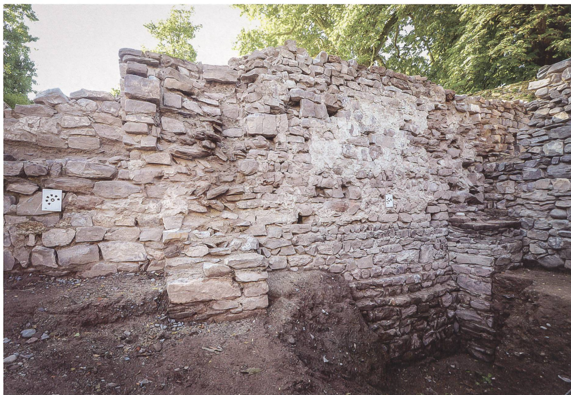
→ Fig. 11 Période savoyarde. Vue de l'élévation interne de la chemise de l'aile sud-est. Un revêtement a été posé après l'arrachage des piles. © Archéotech SA
