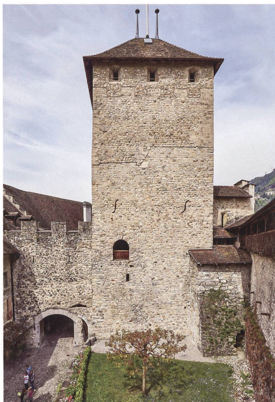
→ Fig. 8 Vue de l'élévation sud de la tour J de Chillon avec son entrée primitive au premier étage; les limites de deux exhaussements ultérieurs ont été marquées par Albert Naef dans le mortier. © Archéotech SA
