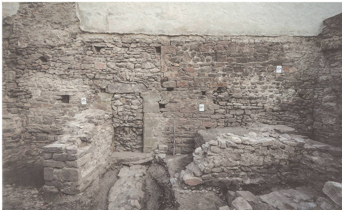
← Fig. 12 Période savoyarde. Vue de l'élévation sud du corps de logis avec de nombreux perçements et reprise, dont une ancienne porte en molasse bien visible dans la partie inférieure et l'adjonction postérieure d'un escalier contre la façade. © Archéotech SA
