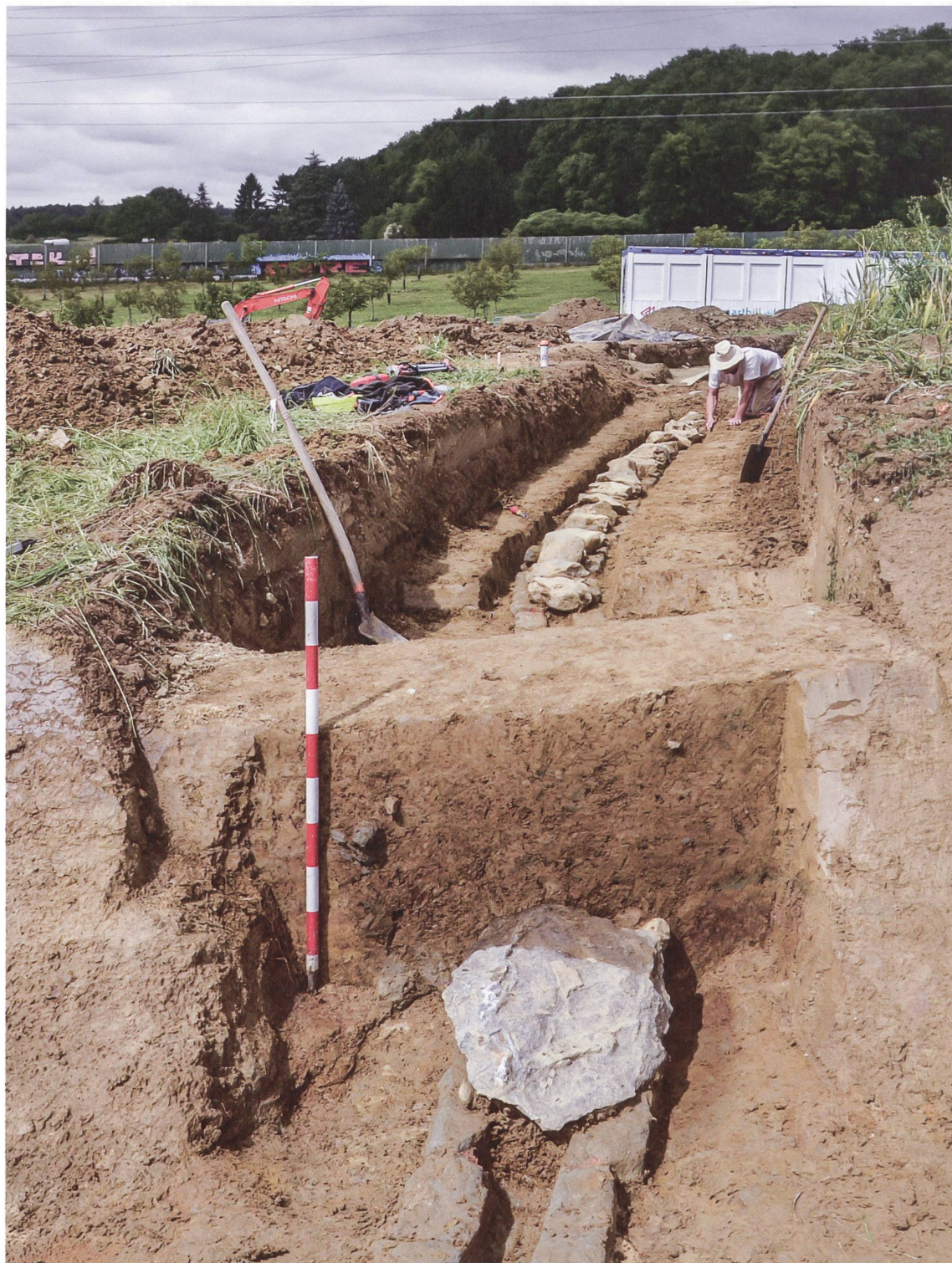
→ Fig. 11 Crissier-Les Têtes. Dégagement de la conduite en molasse d'époque romaine. © Archeodunum SA
