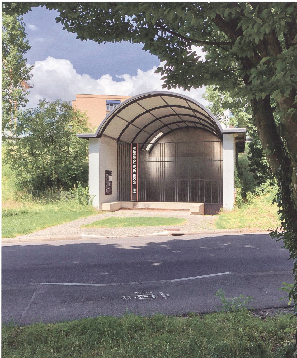
← Fig. 12 Entre le Musée, la mosaïque et la promenade archéologique, des pastilles sur les trottoirs permettent aux visiteurs de s'orienter. À l'arrière de l'image, signalé par un kakémono, le pavillon abritant la mosaïque, construit pour l'Expo 64. © Archéologie cantonale, Lausanne
