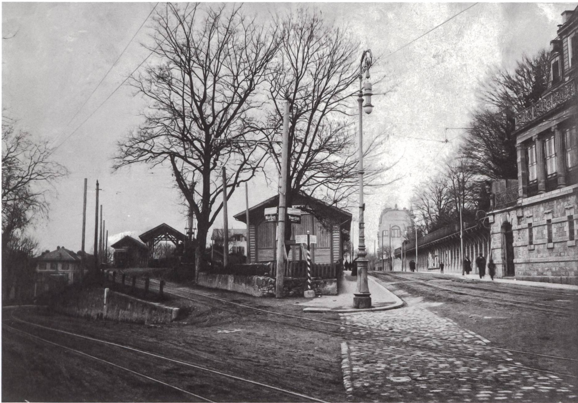
← Fig. 4 Vue de la jonction entre l'Avenue de Morges et l'Avenue d'Échallens, avec au centre la gare de Chauderon. © Frédéric Mayor, La gare du LEB, photographie, 1913, coll. Musée historique Lausanne. P.2.D.16.25.15
