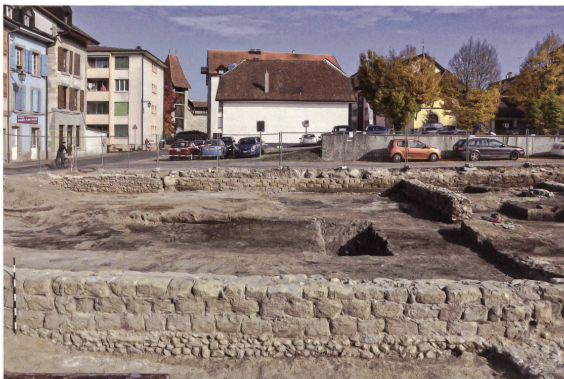
← Fig. 16 Détail du parement interne de la grange B1, constitué d'un appareil régulier en carreaux et boutisses de molasse. © Archeodunum SA, D. Maroelli
