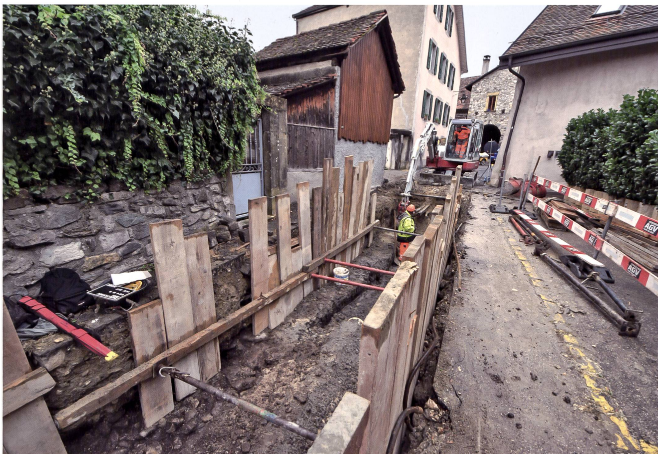
Fig. 9 COSSONAY – Rue du Four 1-6. Ouverture à la pelle mécanique d'un tronçon de la tranchée [©Archéotech SA].
