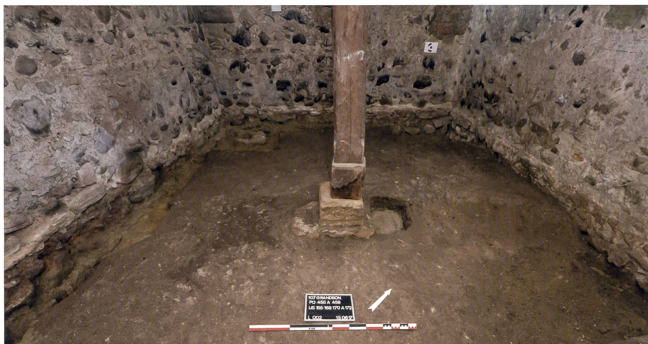
Fig. 14 GRANDSON – Château de Grandson. Vue générale de la cave vers le nord avec le pilier central daté de 1764, le sol de terre battue (US168) et le long des parois les restes des niveaux de sol disparus. Au fond le support du poteau antérieur (458po) [© Archéotech SA].
