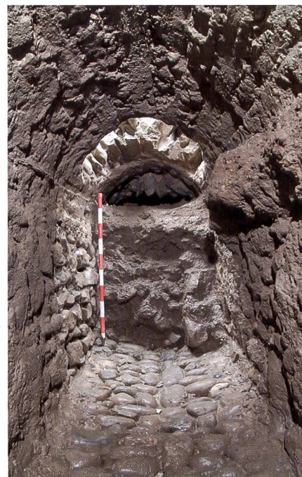
Fig. 3 AUBONNE – Bourg médiéval. Vue de l'intérieur de la galerie, en direction du nord-ouest (© Archeodunum SA, C. Cantin).
