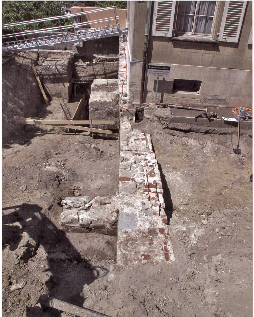
Fig. 26 LAUSANNE – Château Saint-Maire. Le mur d'enceinte de la cour qui entourait la tour, vue vers le nord (© Tera sàrl).
