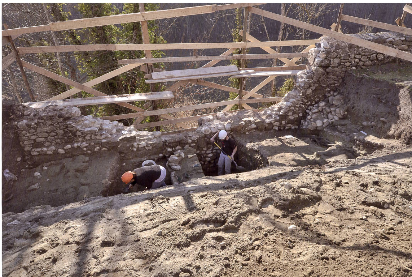
Fig. 28 LUCENS – Terrasses du château. Vue générale de la fouille avec le mur d'enceinte effondré en arrière-plan (© Archéotech SA).
