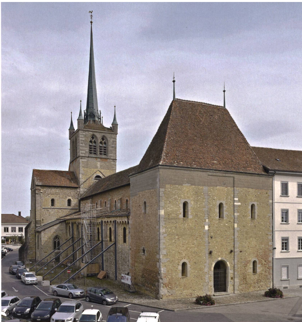
Fig. 3 L'abbatiale de Payerne avec ses contreforts d'acier (© Rémy Gindroz).
