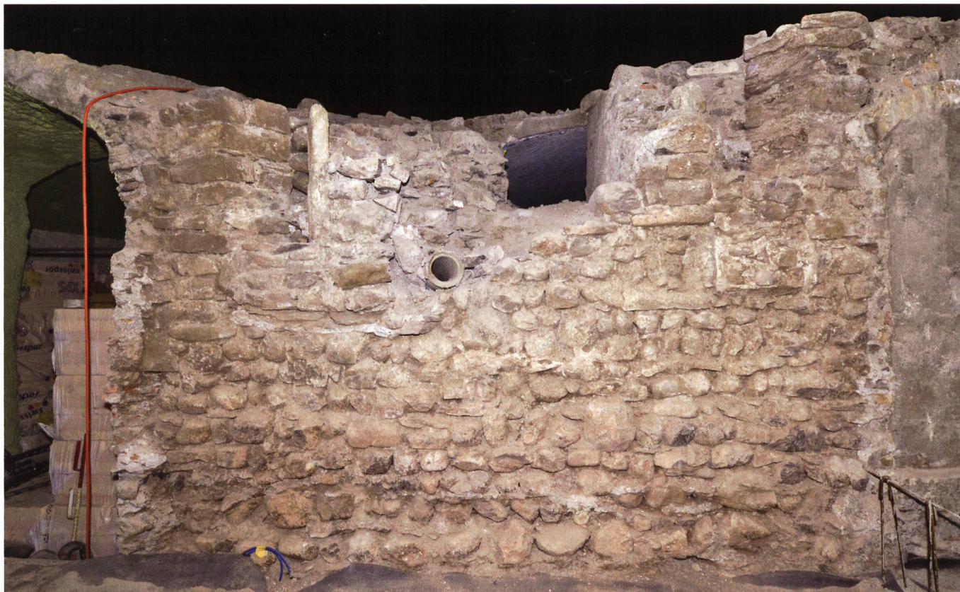
Fig. 20. VEVEY – Rue d'Italie 22. Parement externe du mur de ville. A gauche l'archère orientale avec l'exhaussement de la tablette [photo Archéotech SA, M. Glaus].
